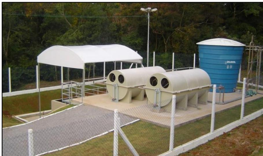
**Figura 110-** Imagem ilustrativa de um sistema Biodisco
